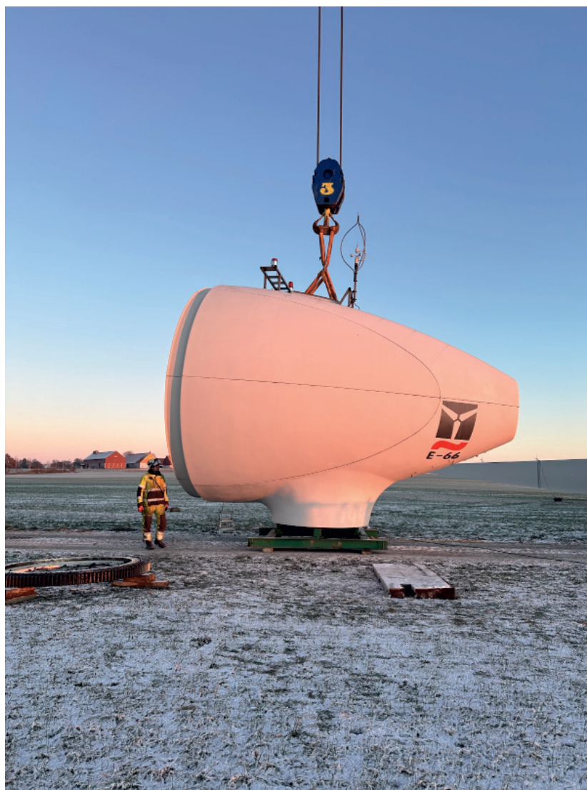
Lyft av maskinhus till Hedagården efter byte av huvudlager
