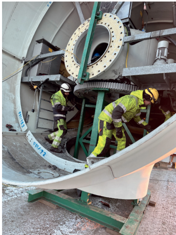
Förberedelse inför lyft av maskinhus på Hedagården
