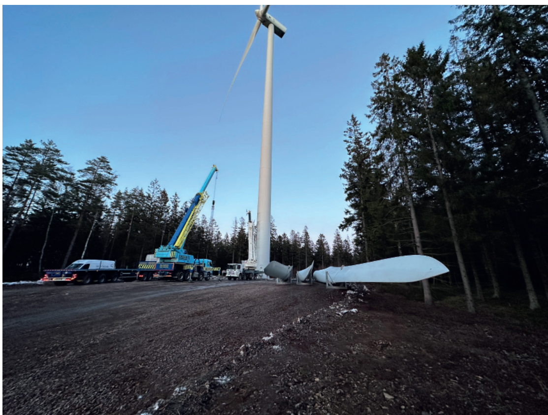
Etablering inför byte av vingar i Fjärås
