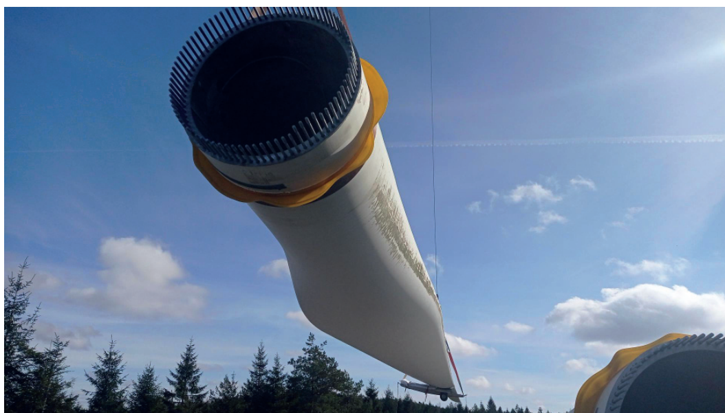
Lyft av vinge i samband med byte i Fjärås
